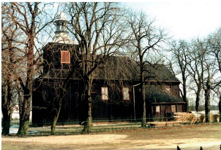
Ryc. 2. Wygląd kościoła parafialnego w czasie prac remontowych przed pożarem. Źródło: http://www.wbc.poznan.pl/dlibra/doc-content?id=19371&from=FBC .
